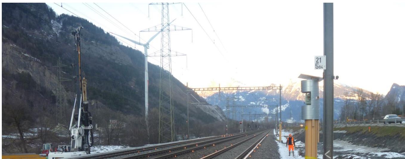
Überwachung Gleis- und Fahrleitungsanlagen, Wildbrücke Halbmit, Trimmis GR).
