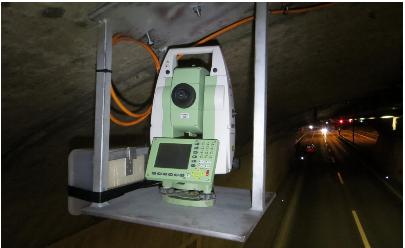
Überwachung Tunnel Rathausen, Ebikon LU.
